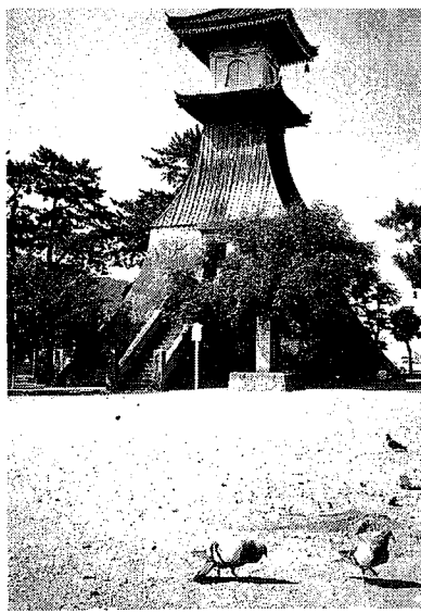
▲慶応元年に建った日本一の高さの灯籠
