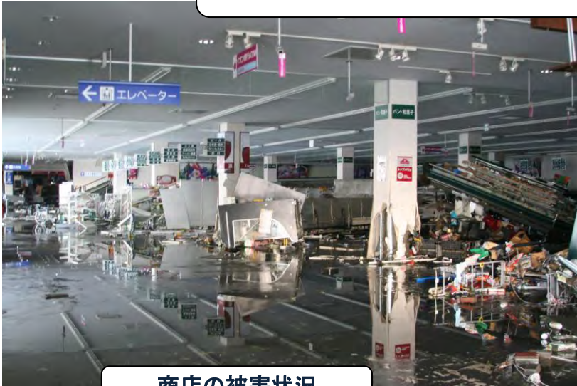
商店の被害状況
